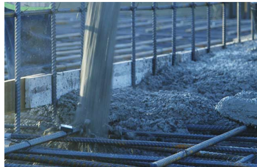
4) Giet het beton
